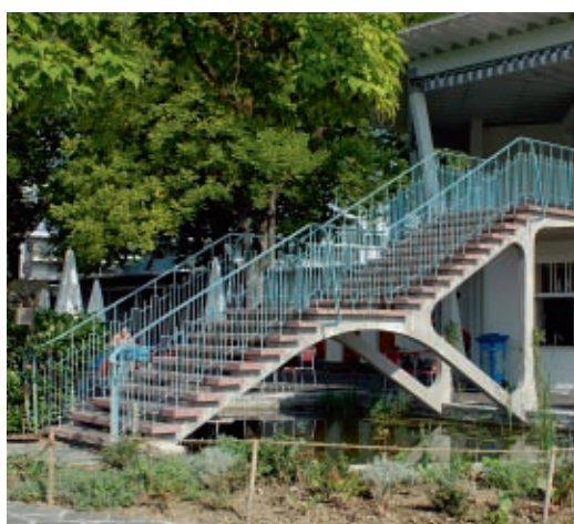
Freitreppe und Pavillon 1949 und 2007 nach aufwändiger Sanierung und Rekonstruktion der ursprünglichen Bepflanzung.
